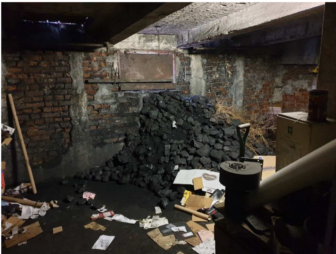
Fot. 7 Pomieszczenie składu opału
