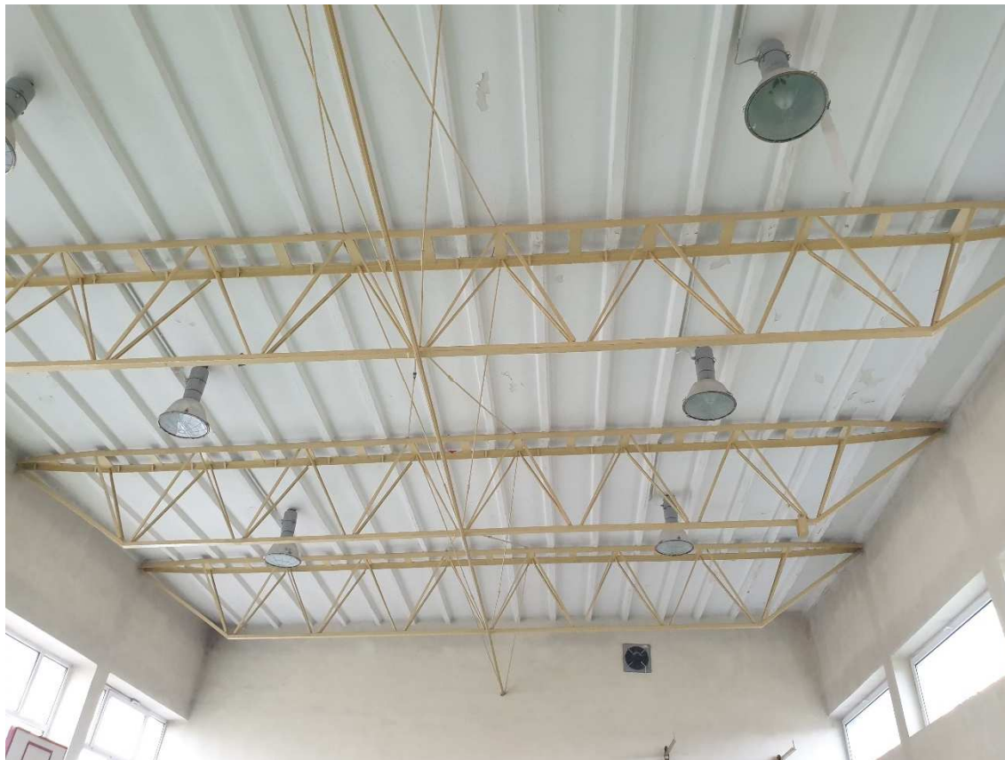
Fot. 20 Dach w sali gimnastycznej
