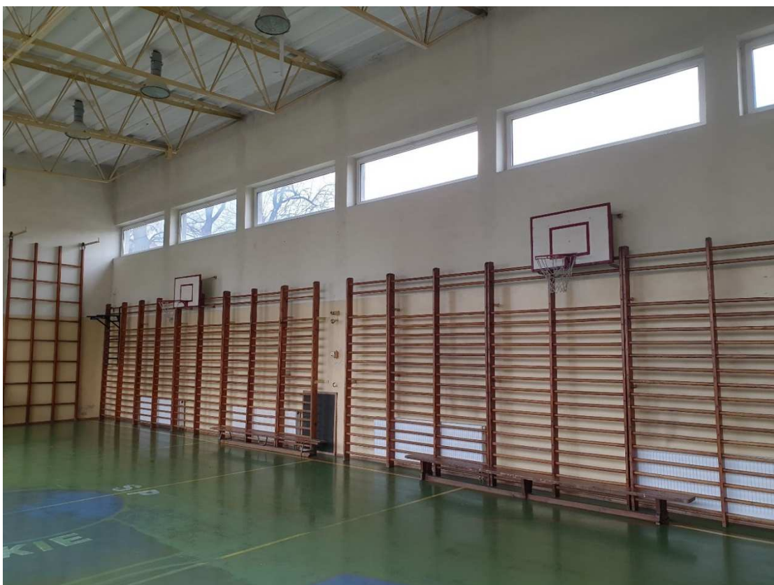
Fot. 19 Widok na okna zlokalizowane w elewacji południowej
