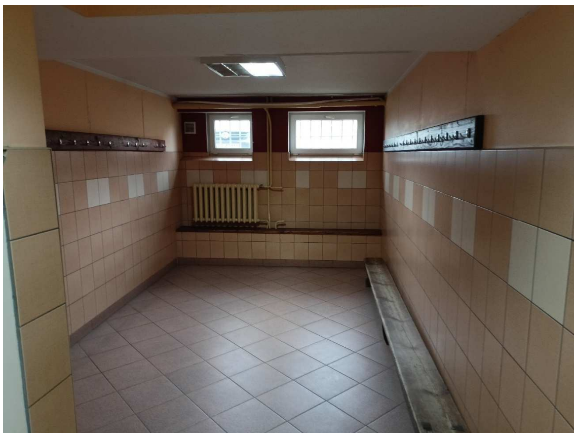
Fot. 8 Szatnia w piwnicy
