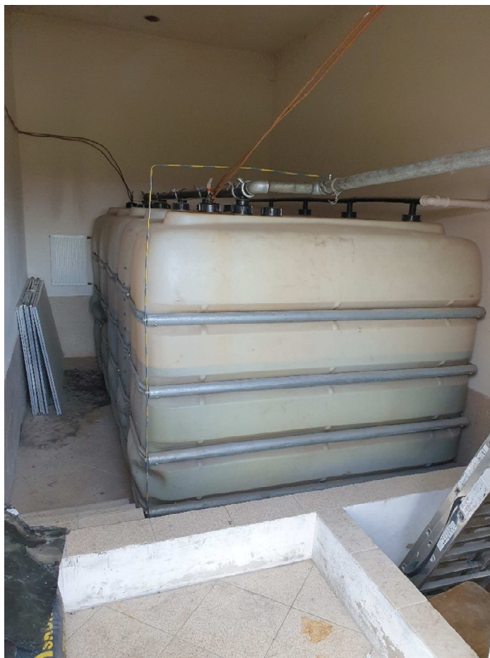
Zdj. 5 Pomieszczenie składu opału.
