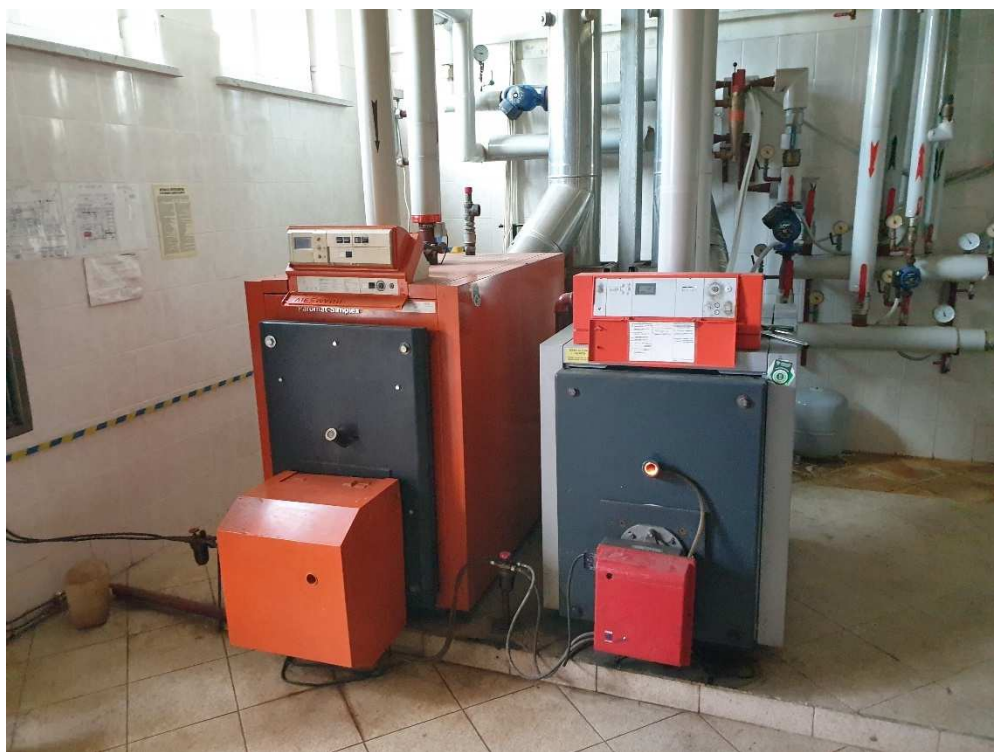
Zdj. 2 Pomieszczenie kotłowni, istniejące kotły olejowe.
