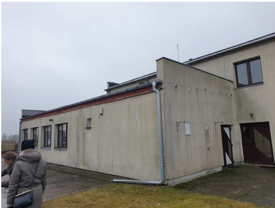
Zdj. 2 Elewacja wschodnia budynku.
