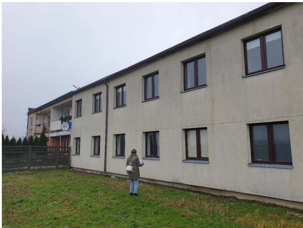
Zdj. 4 Elewacja zachodnia budynku.
