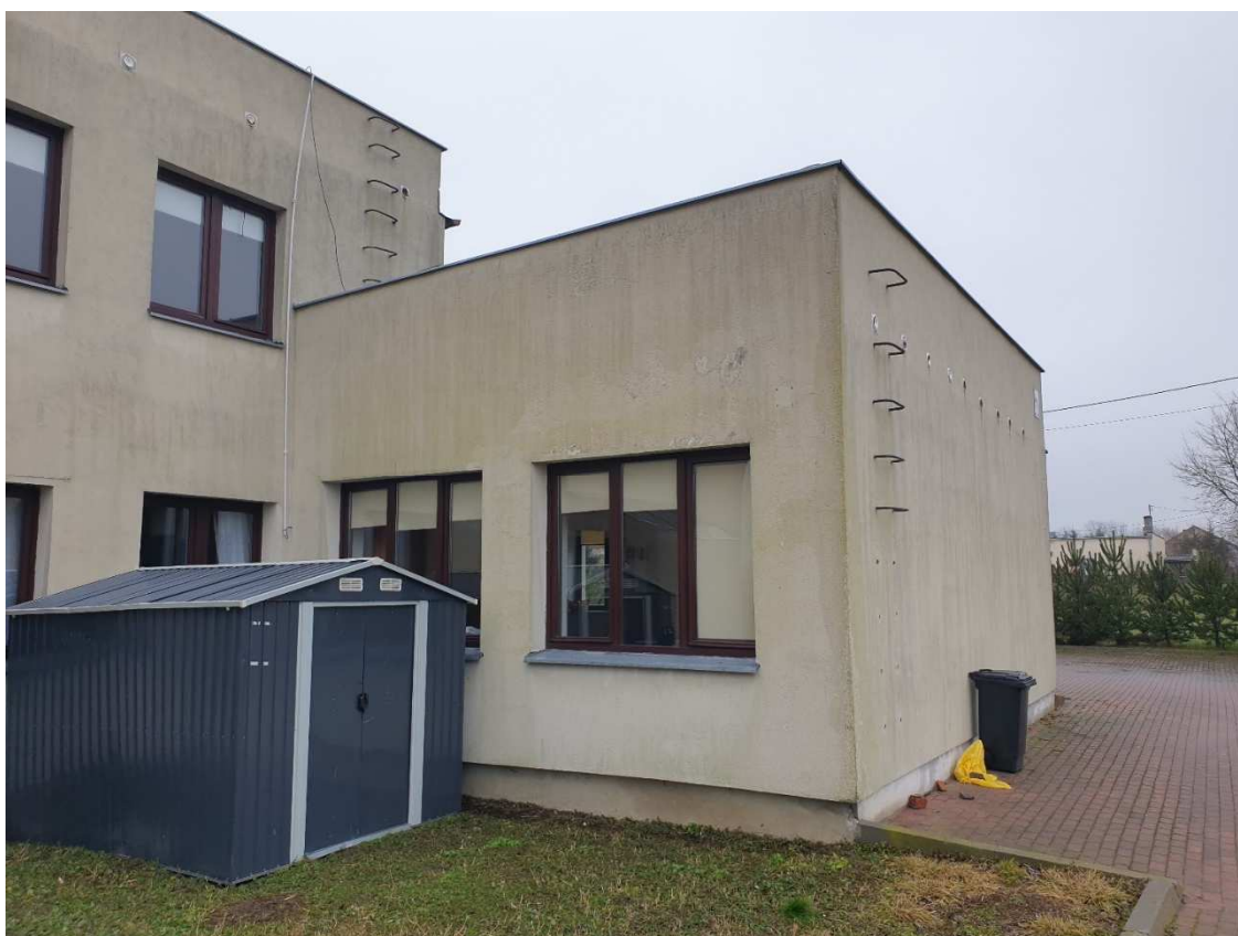
Zdj. 3 Elewacja południowa budynku.
