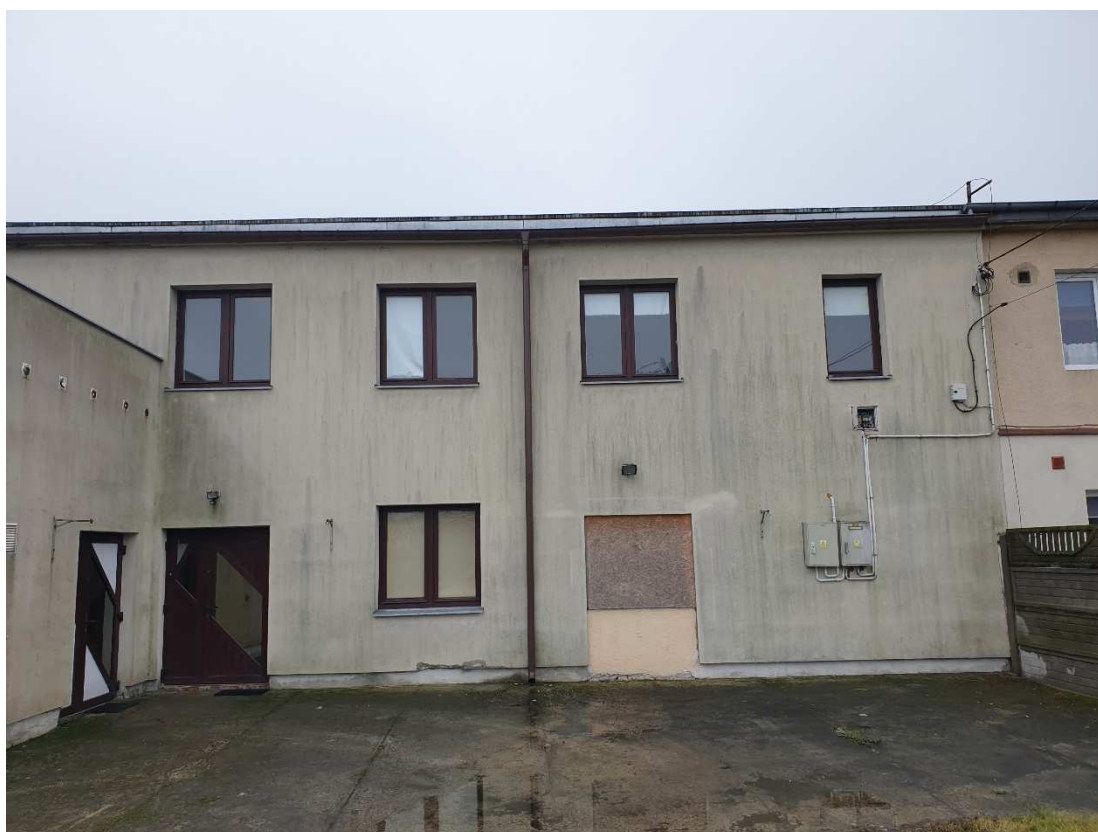
Zdj. 1 Elewacja wschodnia budynku.
