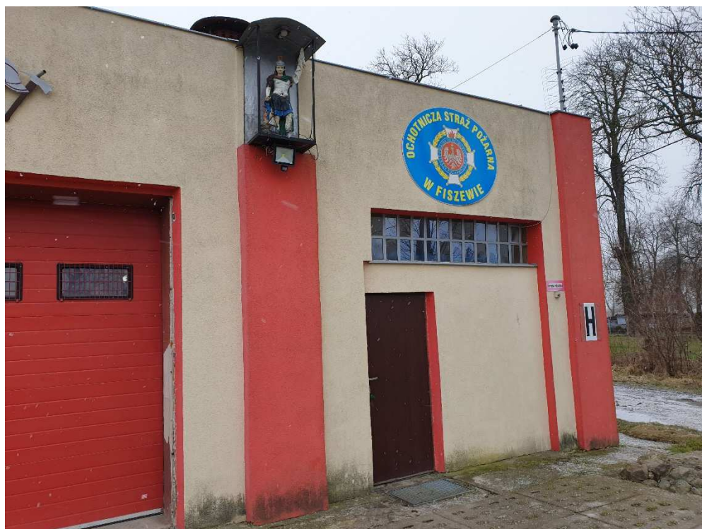
Zdj. 1 Elewacja północno-wschodnia.
