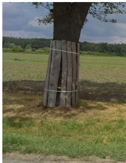
Fotografia 3 Przykładowy sposób ochrony pnia drzewa przed uszkodzeniami mechanicznymi
