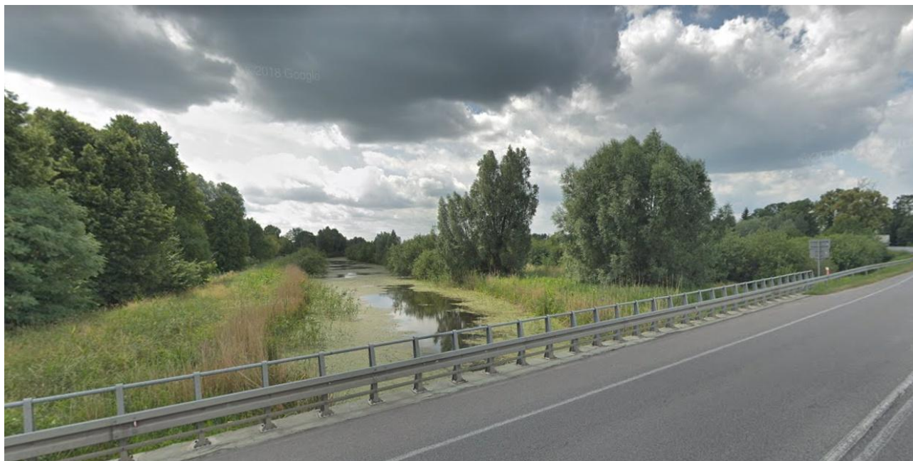
Fotografia 6 Rzeka Fiszewka w rejonie obiektu mostowego w ciągu istniejącego przebiegu drogi krajowej nr 22
