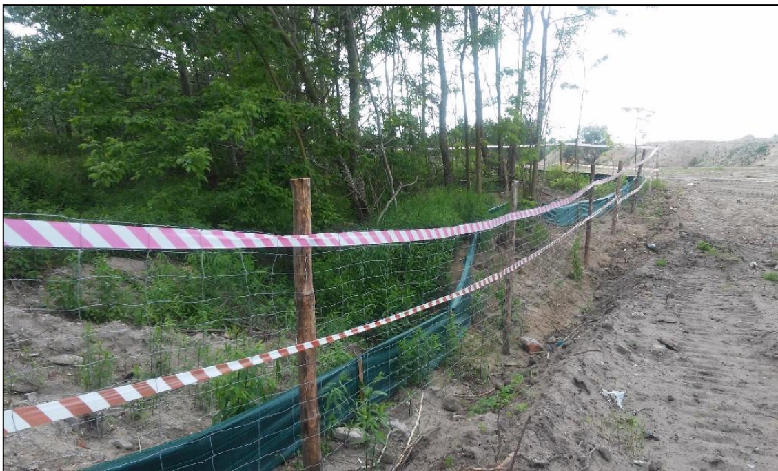
Fotografia 4 Przykład wykonania tymczasowych wygradzeń dla płazów
