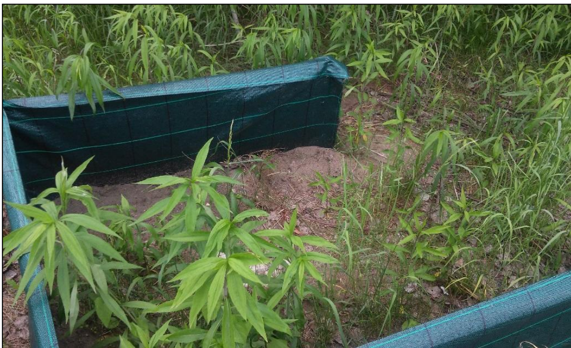
Fotografia 5 Przykład wykonania U-kształtne zakończenie płotka tymczasowego
