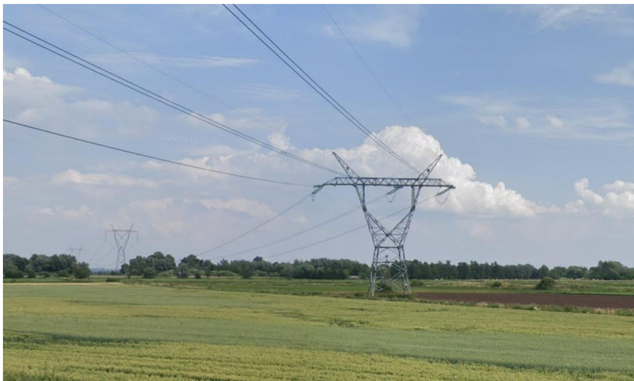
Fotografia 2 Linia elektroenergetyczna 400kV przewidziana do przebudowy w związku z budową obwodnicy Jęglownika
